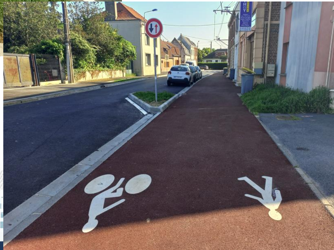
Traversée de Sainghin-en- Weppes, mixité avec piétons en élargissant un trottoir
