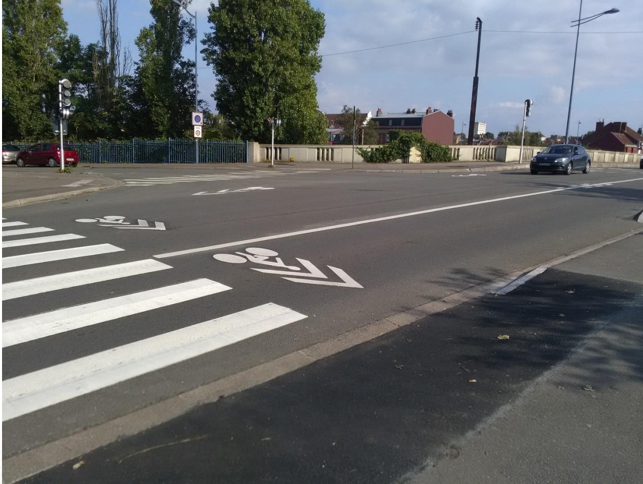
Pont Leclerc – Arras – marquage réglementaire mais peu visible
