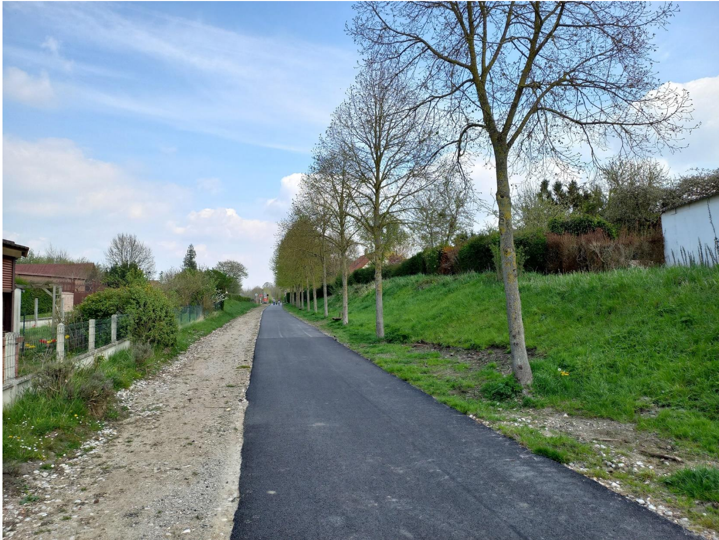
VV Saint-Riquier – Somme (ancienne voie ferrée)
