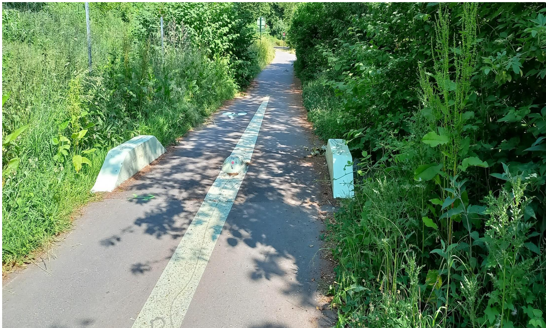
Angres – EV5 – dispositif anti véhicule léger laissant passer les tracteurs
