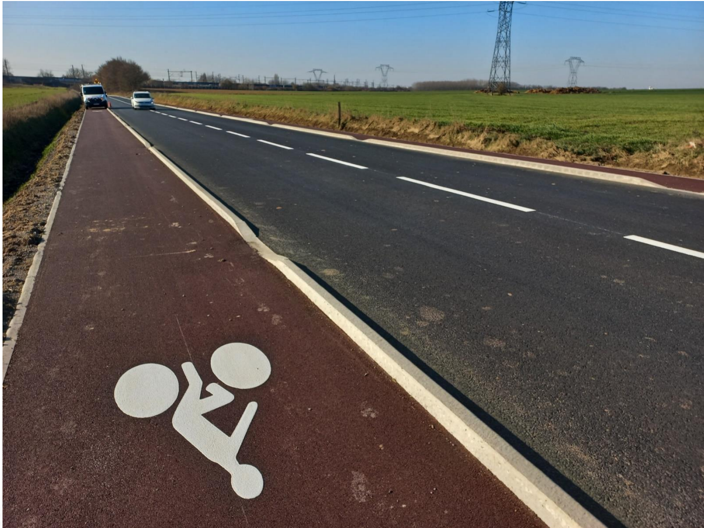
Piste uni bordurée de 2 m sur emprise étroite – M 19 Sainghin en Mélantois
