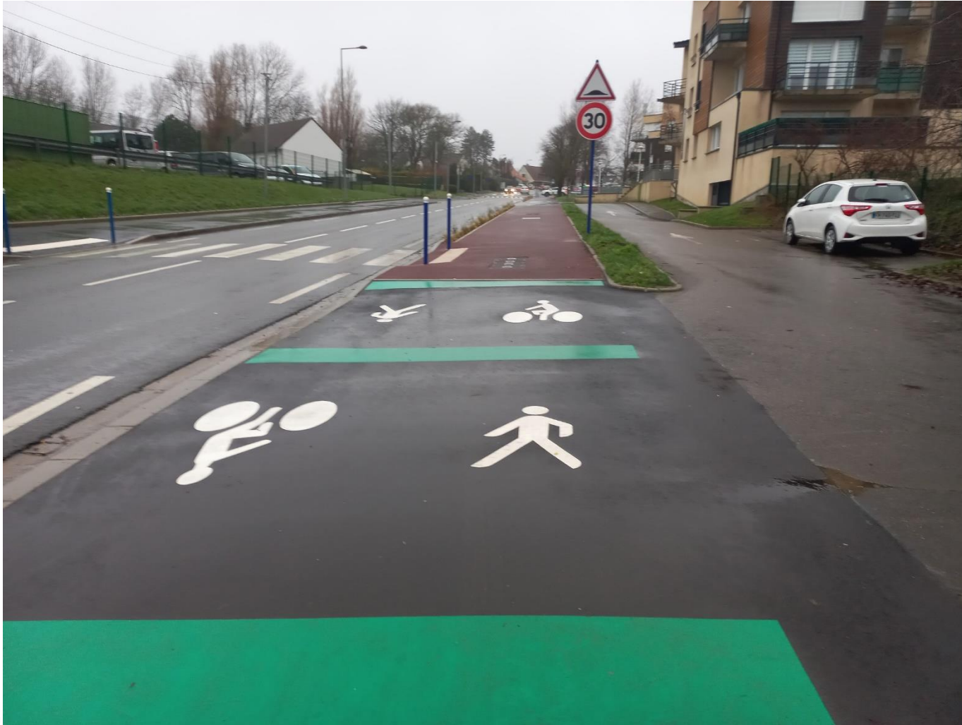
Outreau – trottoir élargi à 3 m avec marquage des traversées
