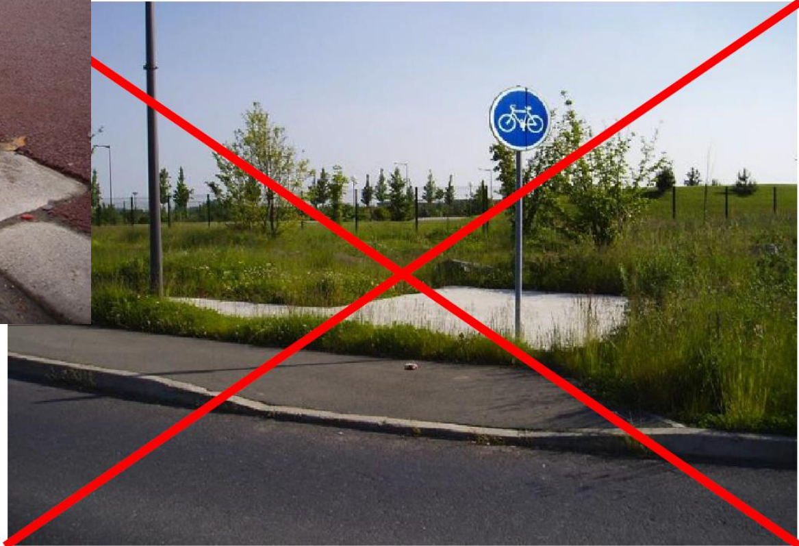
Exemple d'une entrée de piste cyclable avec bordure à proscrire
