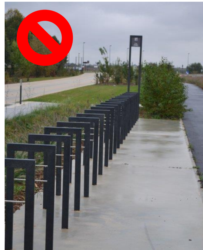
Trop d'arceaux (carrés) implantés trop proche les uns des autres
