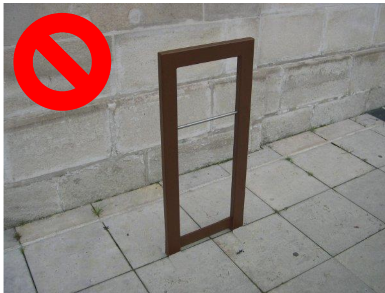
Arceau (carré) implanté trop proche du mur
