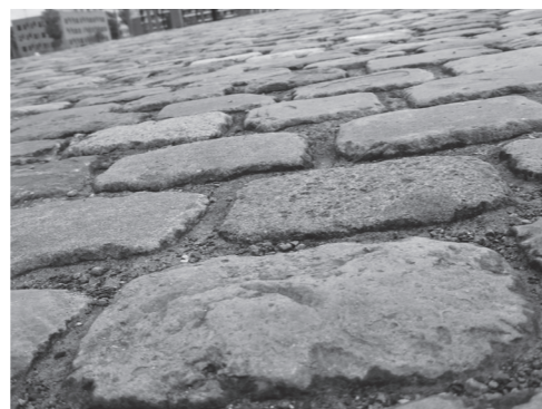
Noter le travail technique remarquable pour recréer l'inconfort des joints de pavés « à l'ancienne ».
