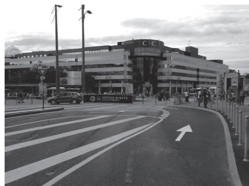
Fermeture de l'avenue Willy Brandt pour relier les deux gares et limiter le trafic de transit
