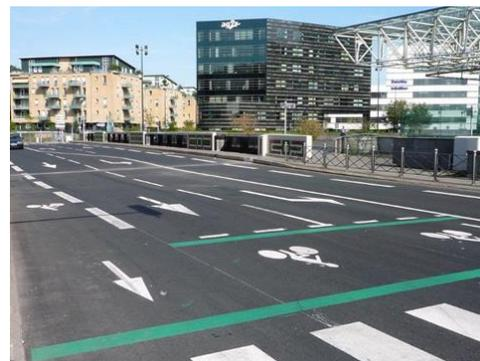
Dernièrement, les recommandations du CERTU ont évoluées. En l'absence d'une bande cyclable en amont du sas, il est demandé de réaliser des bandes d'accès étroites sur une longueur d'une dizaine de mètres. En l'absence de bandes d'accès le SAS ne peut plus être matérialisé.
