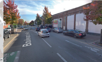
54. Bd de Strasbourg - Rupture de bande et rétrécissement aux îlots - Google SView
